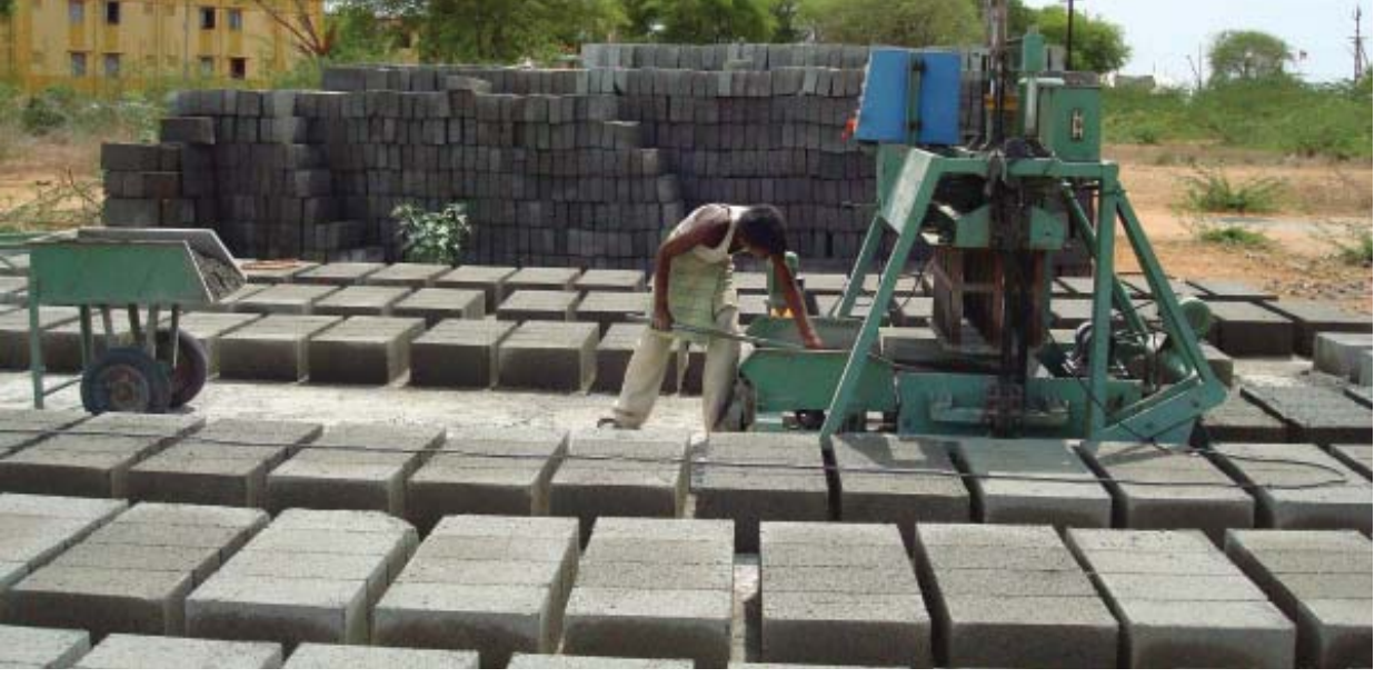
वाम्बे के अन्तर्गत त्रिचि तमिलनाडु में प्रदर्शनार्थ मकानों के निर्माणों के दौरान प्लाई ऐश ब्लाकों का स्थल पर उत्पादन
