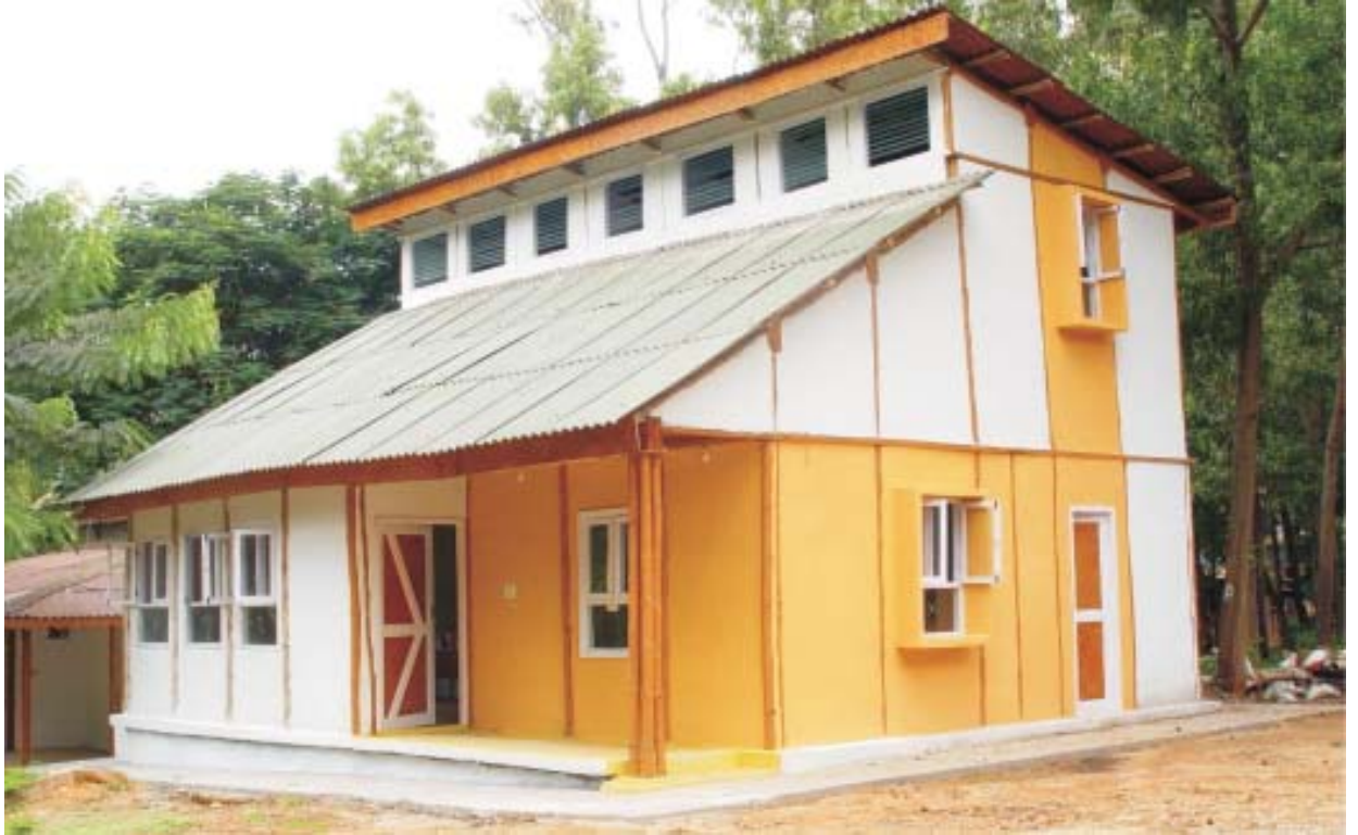
आईपीआईआरआईटीआई, बंगलौर में दो मंजिले बांस आवासीय प्रणाली के निर्माण के लिए बीएमटीपीसी द्वारा विकसित प्रौद्योगिकी
